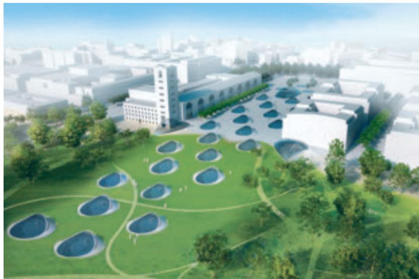
Im Einzelnen sind folgende Änderungen vorgesehen: Die vier Glasgitterschalen für die Zugänge zum neuen unterirdischen Durchgangsbahnhof werden kleiner als bislang geplant. So wird die Breite der Glasgitterschale am Bahnhofsturm um fast 11 Meter auf 23 Meter verkleinert. Damit kommt der Turm des denkmalgeschützten Bonatz-Gebäudes besser zur Geltung.
