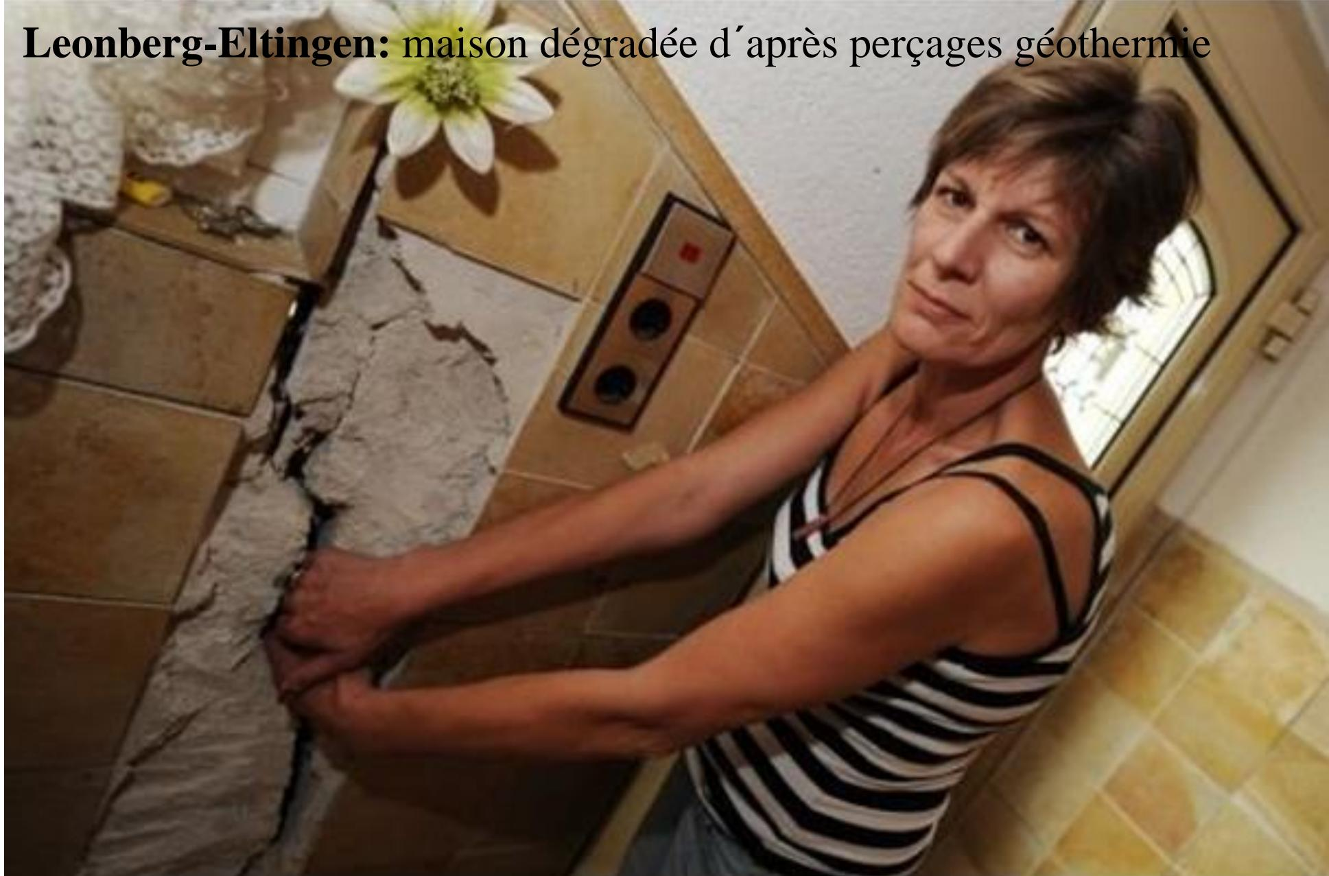
In Leonberg-Eltingen sind die Häuser nach einer Erdwärme-Bohrung regelrecht zerrissen. STZ 8.8.2011
