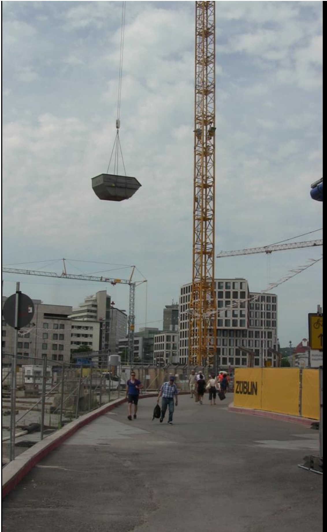
Schwebende Kranlast über Fußgängern auf dem Kurt-Georg-Kiesinger-Platz; Nordausgang HBF aufgenommen von Peter Müller am 11.7.2016 gegen 11.00 Uhr
