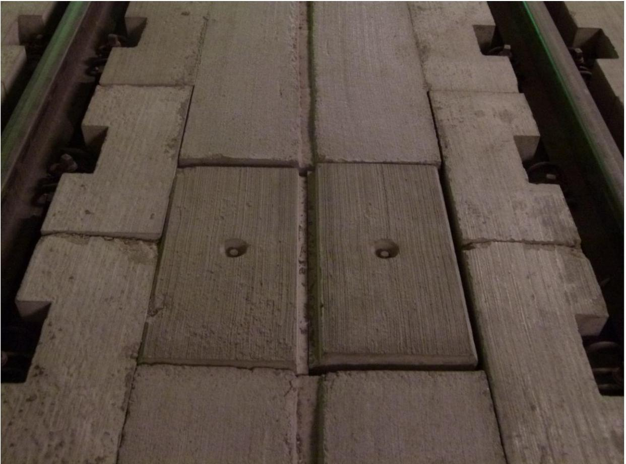
Abb. 3.2.: Tunnelsohle mit Betonsteinen (ausgeführt im Katzenberg-Tunnel)
