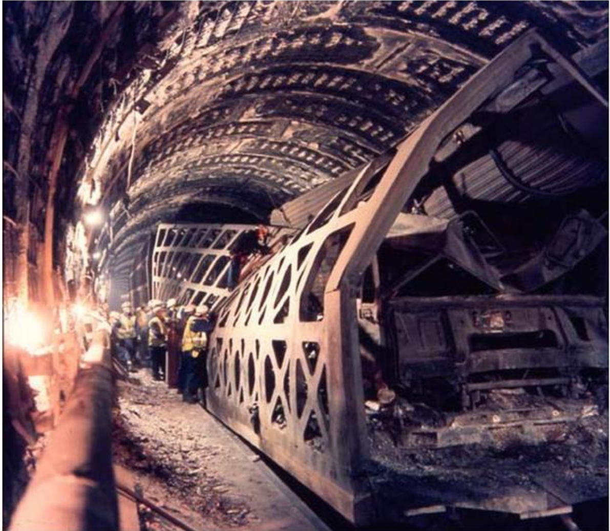
Abb. 7.2: Nach dem Brand am 11.Sept. 2008 im EURO-Tunnel zwischen F u. GB
