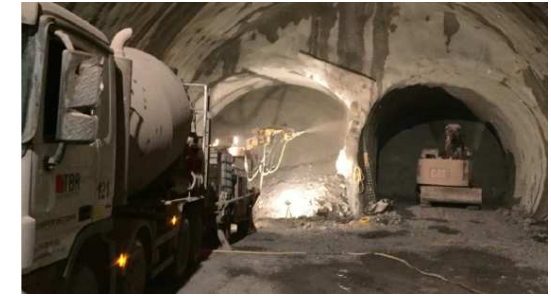
PFA 1.6a Tunnel Obertürkheim Vortrieb 5.270 m (in beide Richtungen)
