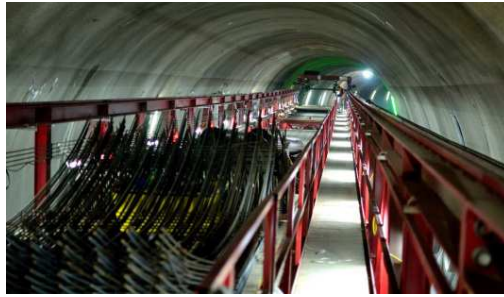
PFA 1.5 Tunnel Bad Cannstatt Vortrieb 5.372 m (in beide Richtungen und Vortrieb Kriegsberg)
