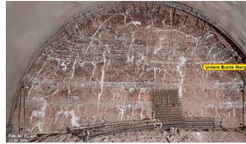
PFA 1.2 Fildertunnel Vortrieb 6.615 m, 2. Schildfahrt, Spritzbetonvortrieb im mittleren Fildertunnel
