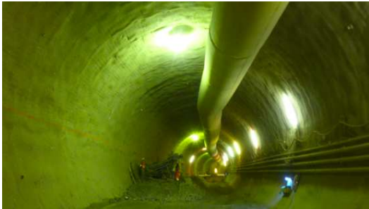
PFA 1.5 Tunnel Feuerbach Vortrieb 2.927 m, inkl. Zwischenangriff Prag
